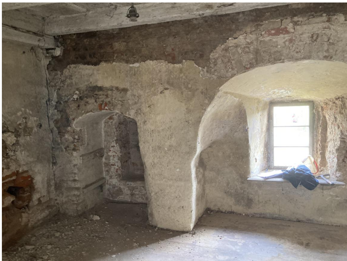
Rys. 10 Pokój dzienny na piętrze, ściana wschodnia – widoczny oryginalny łęk strzelnicy północnej z lewej stron (parapet był rozkuty) i rozkuta wnękę po strzelnicy południowej (z nowo założonym łękiem i dużym oknem)
