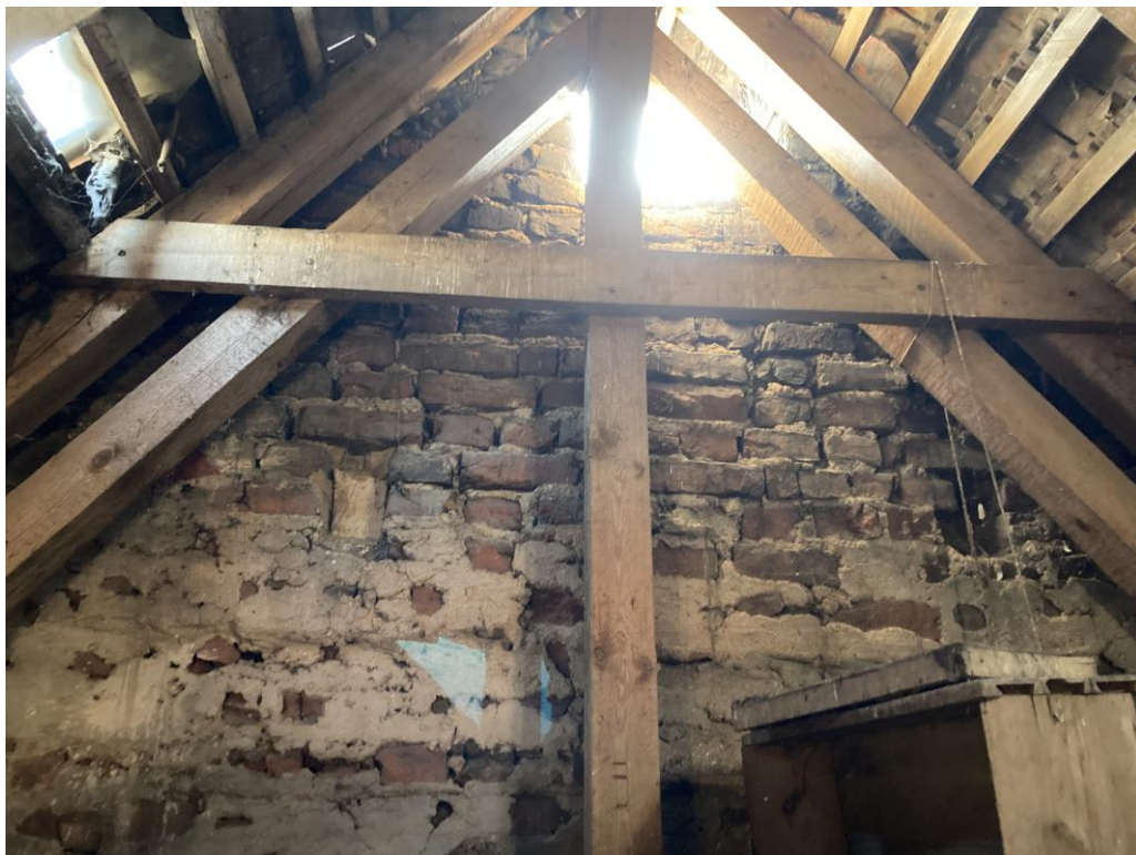
Rys. 15 Widok na ścianę szczytową (nowożytną, w formie postogotyckiej) ustawioną na murze południowym baszty. Poniżej jętki widoczne gniazda po dwóch płatwiach wcześniejszej więźby.
