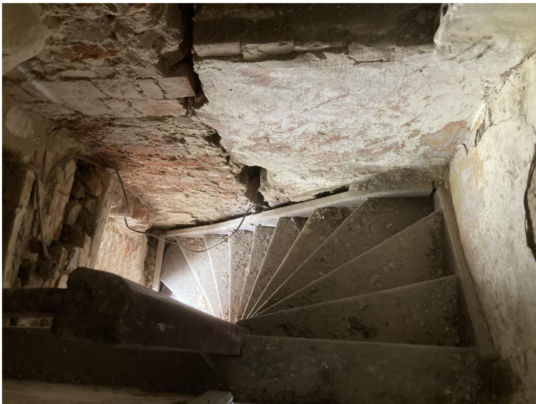
Rys. 12 Klatka schodowa z widokiem na ścianę północną – widoczną spękanie muru, przenicowana bruzda po stropie (cegły wozówki) oraz zamurowana wnęka po strzelnicy w ścianie bocznej
