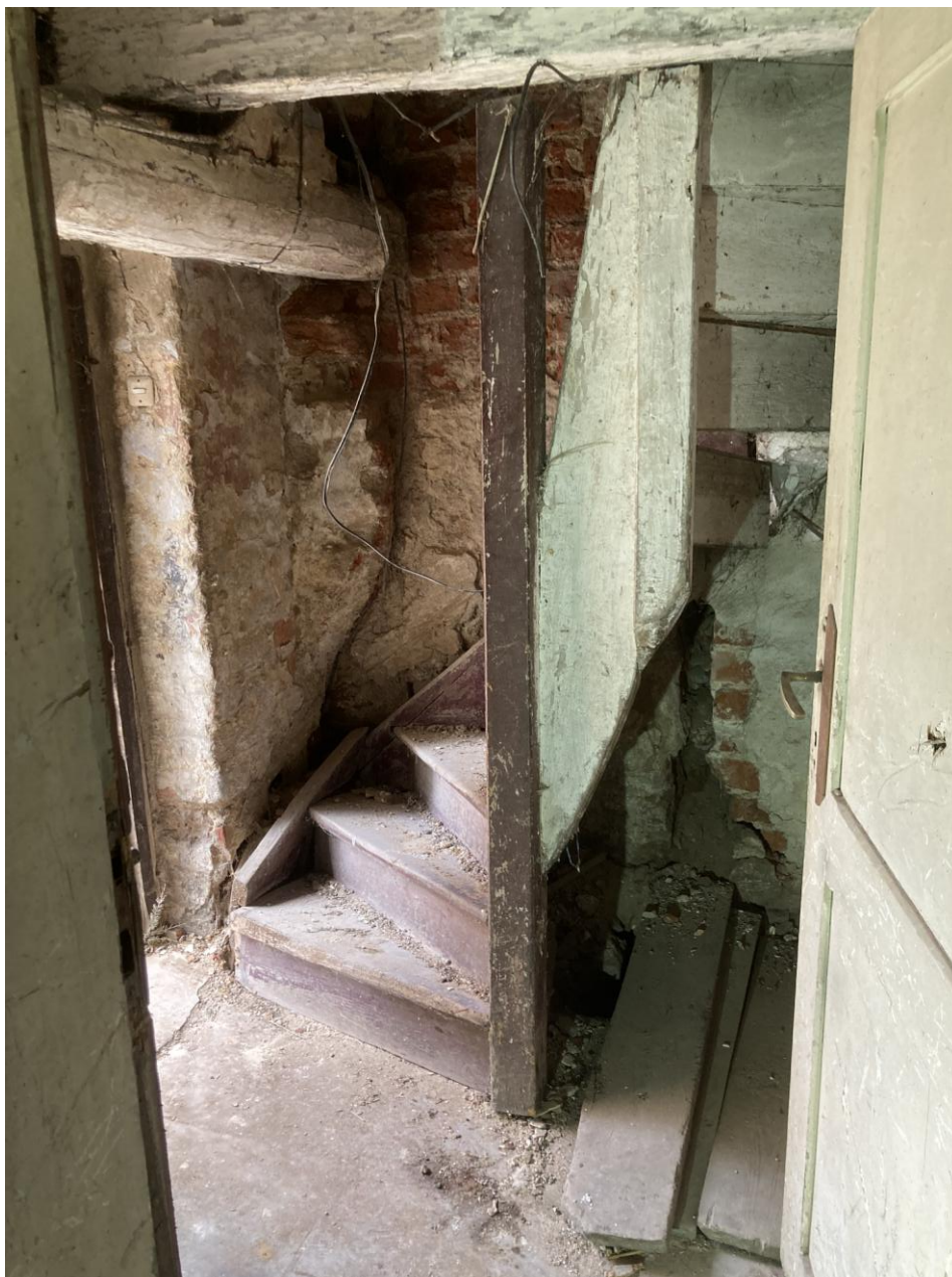
Rys. 9 Sień – widok w kierunku północno-zachodnim. Widoczne podkucie ściany gotyckiej w celu osadzenia muru, ślad po wcześniejszych (bardziej stromych) schodach, przemurowane ościeże drzwi wejściowych i zastonięty deskami szyb wykuty w sklepieniu piwnicy
