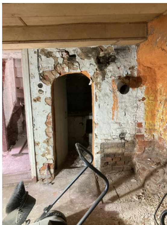
Rys. 8 Wejście do kuchni (łęk koszowy), z drzwiami z desek; widoczne skucie muru wschodniego w pokoju dziennym i wyjście do sieni (wtórnie dostawione do narożnika kuchni)
