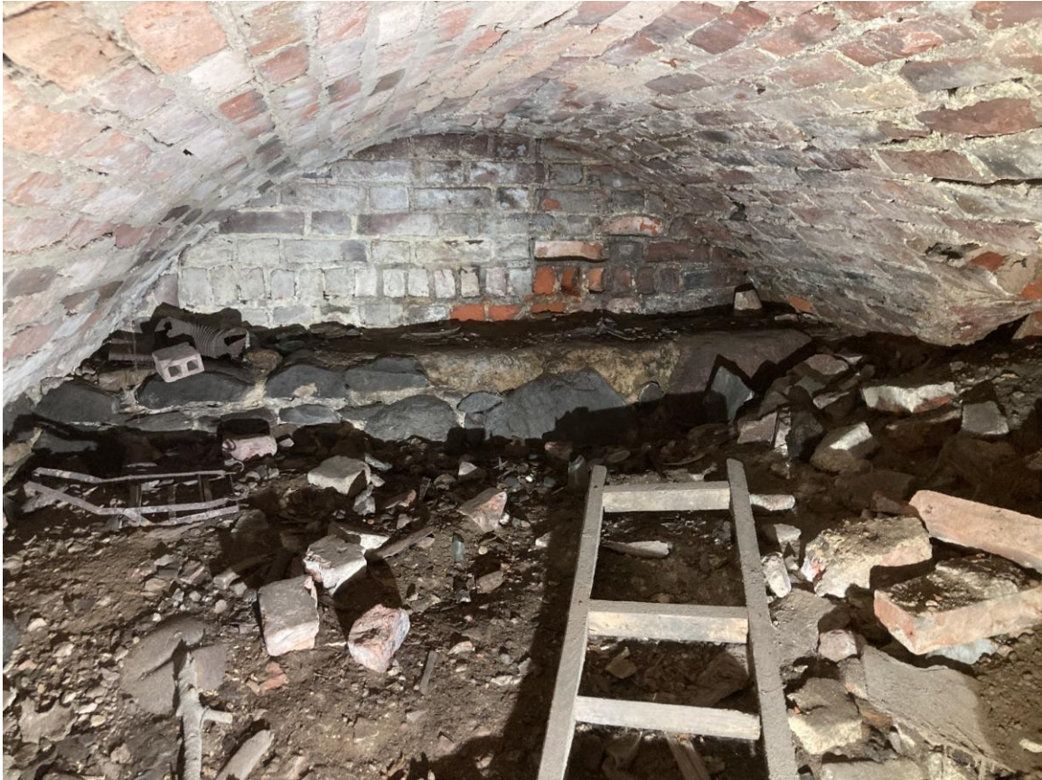
Rys. 5 Wnętrze piwnicy – widok w kierunku południowym (po prawej widoczna awaria sklepienia i zasypane wejście do piwnicy)
