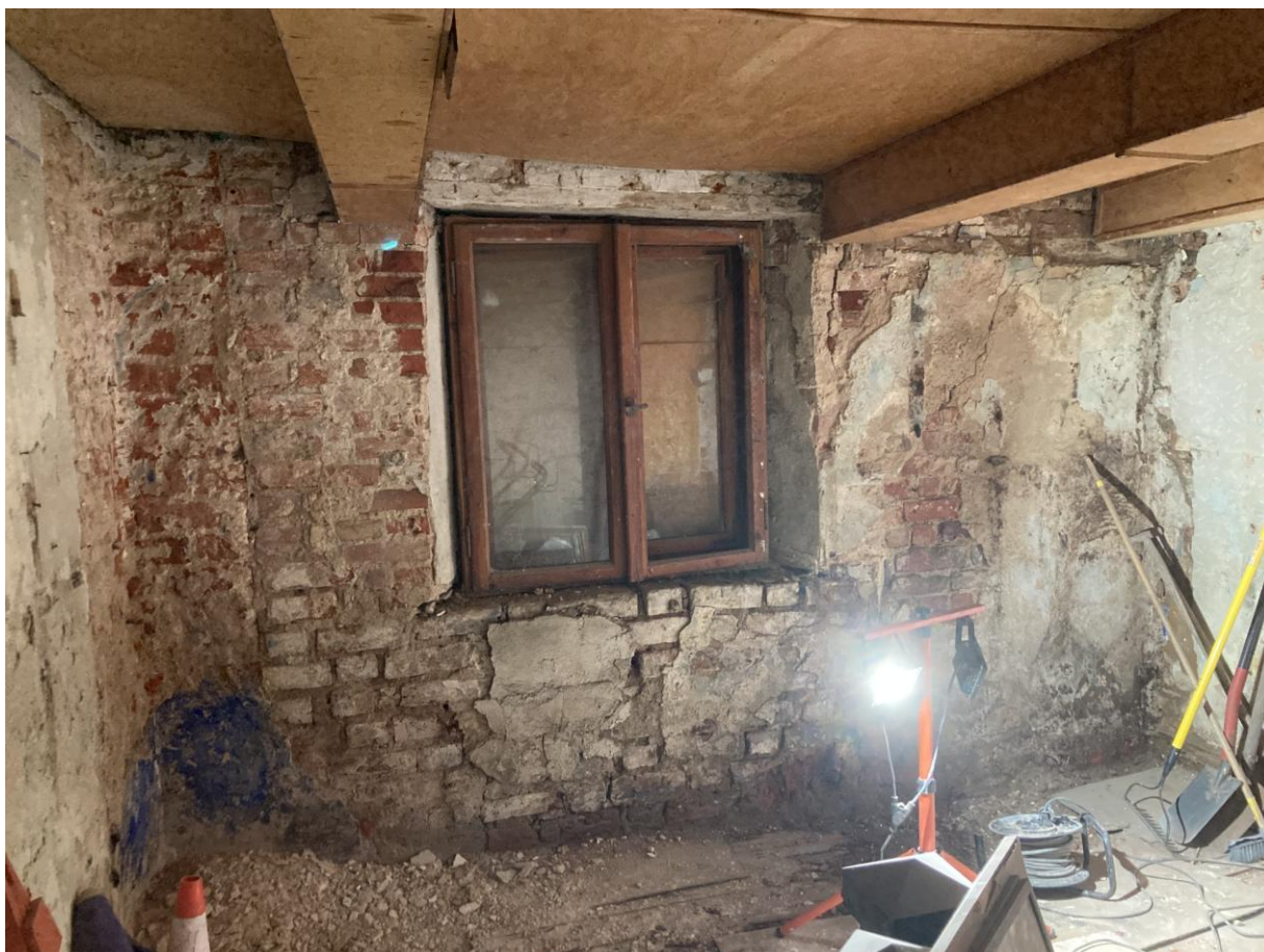
Rys. 7 Pokój dzienny na parterze – widok na ścianę zachodnią (widoczne skucie muru gotyckiego i pionowa fuga)
