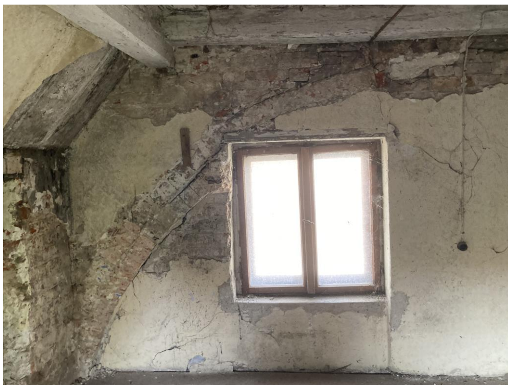
Rys. 11 Ściana zachodnia na Piętrze – widoczny fragment zniszczonego łęku, narożnik południowo-zachodni, oryginalne opracowanie muru gotyckiego ściany południowej oraz rozkute glify danwej strzelnicy (następnie komina i przejścia na poddasze)
