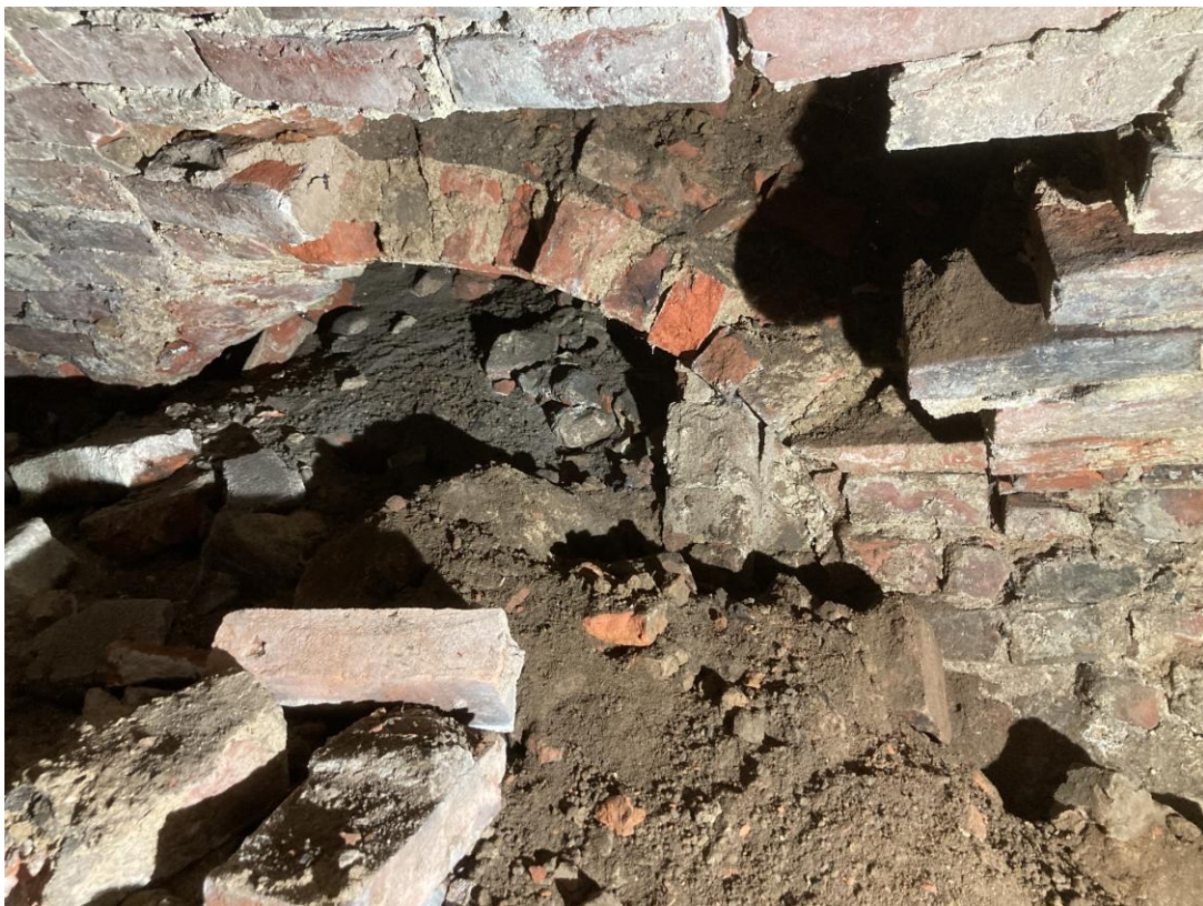
Rys. 6 Pierwotne wejście do piwnicy w ścianie zachodniej (kryte łękiem odcinkowym)
