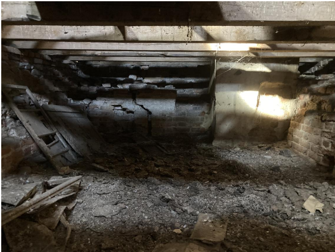
Rys. 14 Poddasze (dawne 2 piętro) – widoczna odsadzka popierowtym poziomie stropu oraz belki tramowe współcześnie więźby (z ok. 1920 r.). Na stropie z ok. 1850-1880 leży polepa. W narożniku widać partę komina przemurowaną (został on od wysokości korpný murów obwodowych przemurowany cegłą maszynową prawdopodobnie w trakcie wymiany wieźby).
