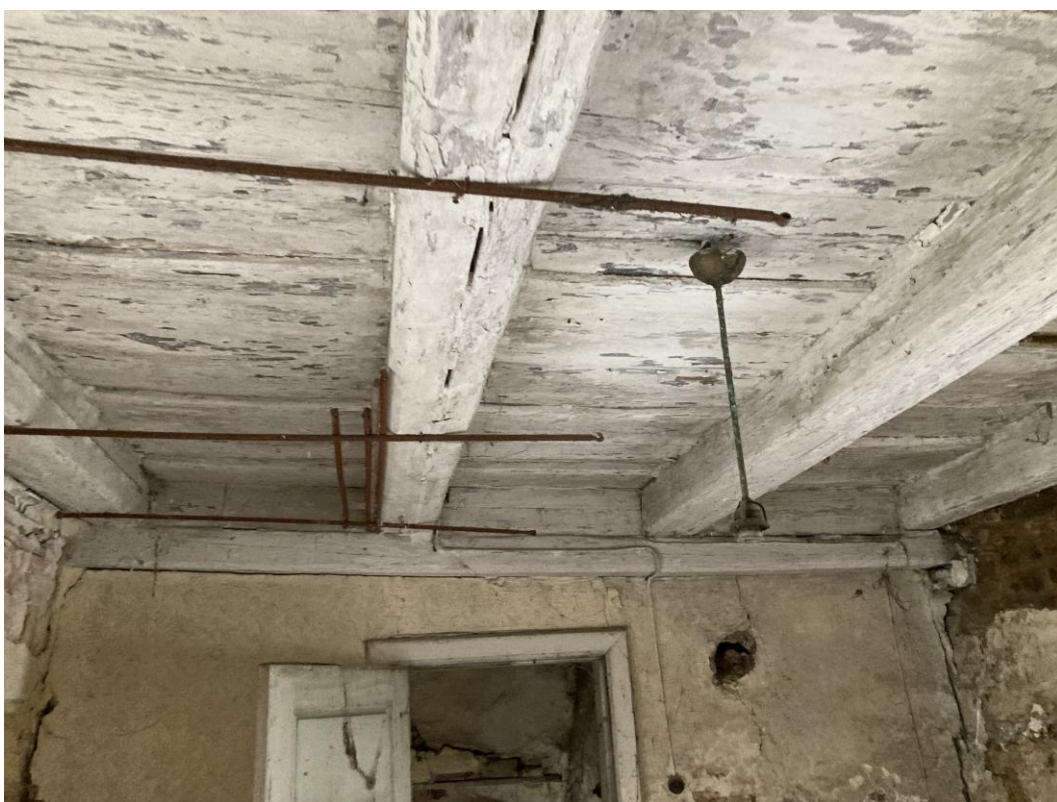
Rys. 13 Strop nad piętrem z ok. 1850-1880 r. Widoczna górna partia komina i przejście do klatki schodowej (ściana z desek, tynk na macie słomianej)
